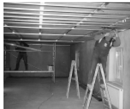
Arbeiten an der Kegelbahn Niederlomotzsch. Nach dem Abriss erfolgt der Wiederaufbau.
