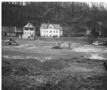
Geländeregulierungsmaßnahmen für den Neuaufbau des Kindergartens in Zehren
