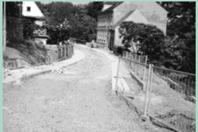
Baufortschritt auf der Lommatzcher Straße in Zehren
