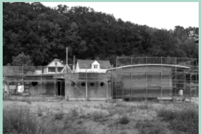
Baufortschritt Kindertagesstätte Zehren mit Blick von der Lommatzcher Straße
