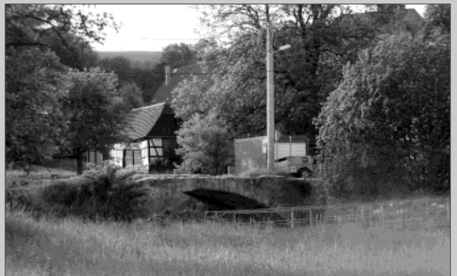
Baubeginn Ketzerbachbrücke am Sportplatz Schieritz
