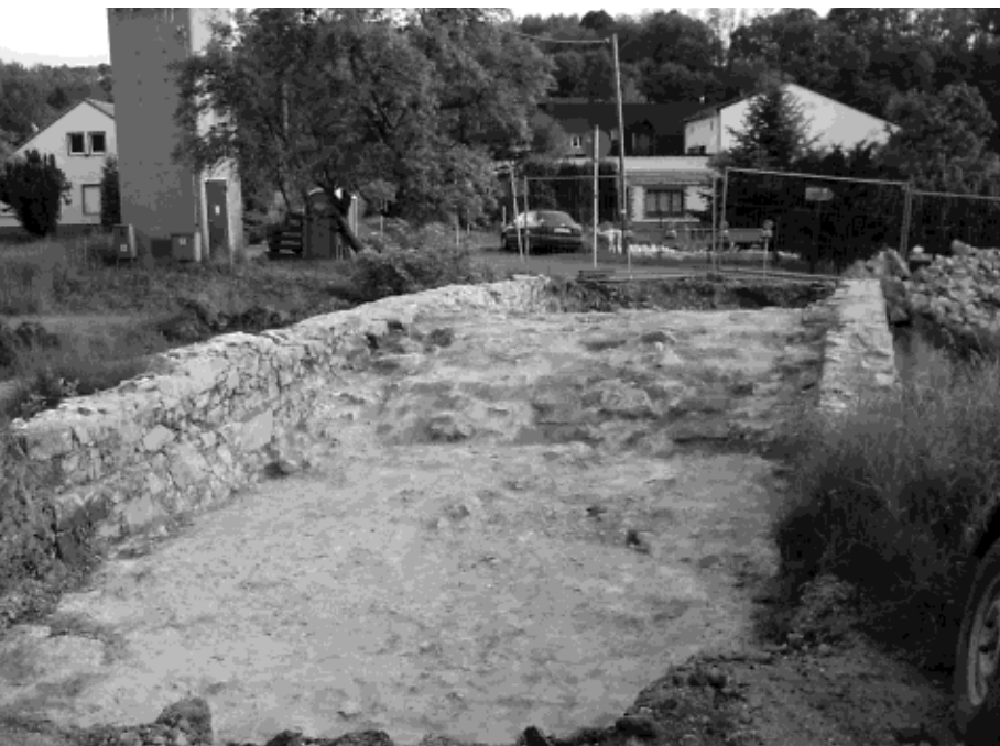
Freigelegter Brückenkörper der Brücke über den Ketzerbach am Sportplatz in Schieritz
