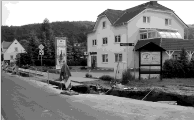
Regenwasserkanal und Gehwegbau Nieschütz
