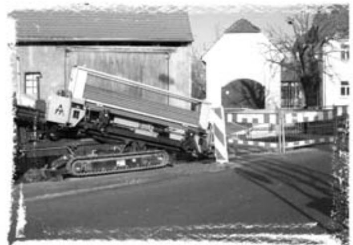
Verlegung Trinkwasserleitung in Schieritz
