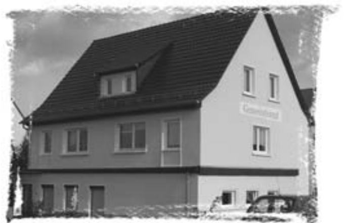
Das Gemeindeamt nach der Sanierung
