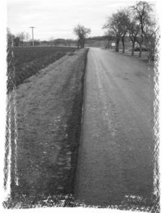
Instandsetzungsarbeiten – Straße nach Löbsal, vom Golkwald kommend, rechts Wanderparkplatz
