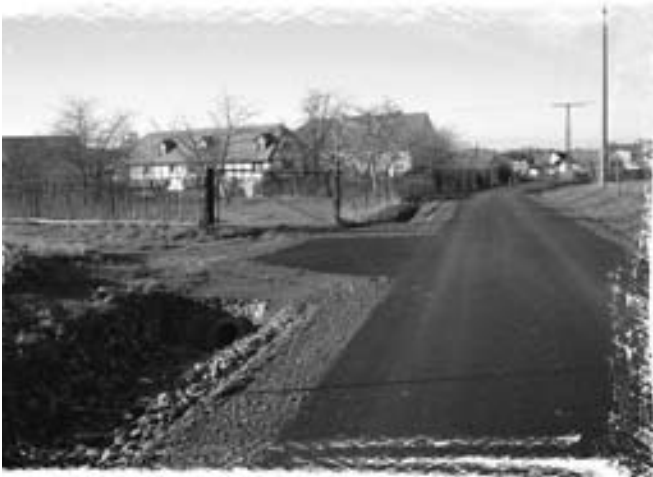
Ortsumgehungsstraße Diera nach der Instandsetzung
