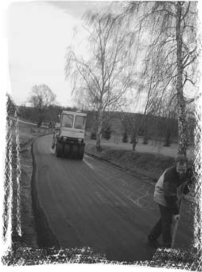
Instandsetzungsarbeiten – Straße Oberlommatsch - Naundorf
