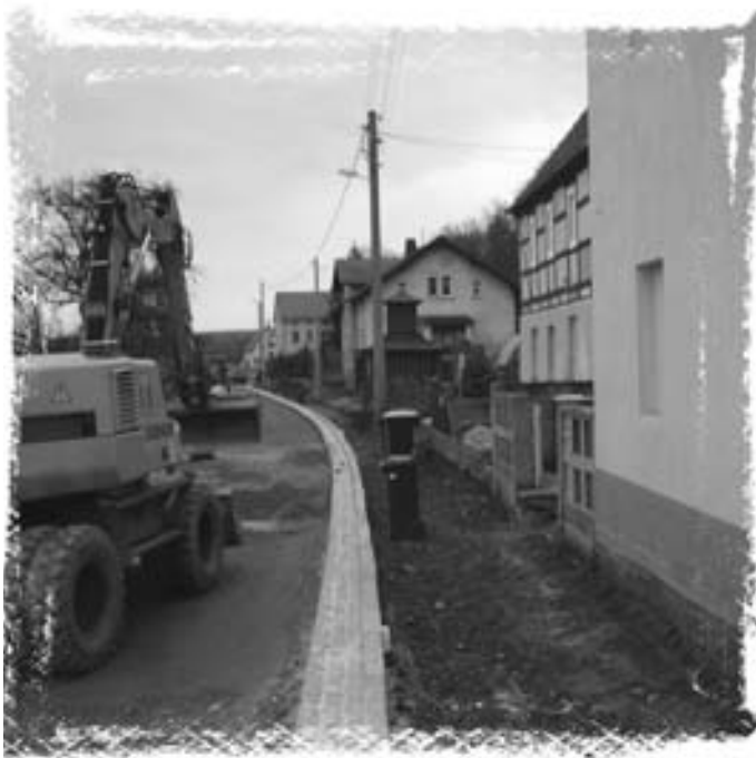
Bei den umfangreichen Bauarbeiten an der Niedermuschützer Straße in Zehren
