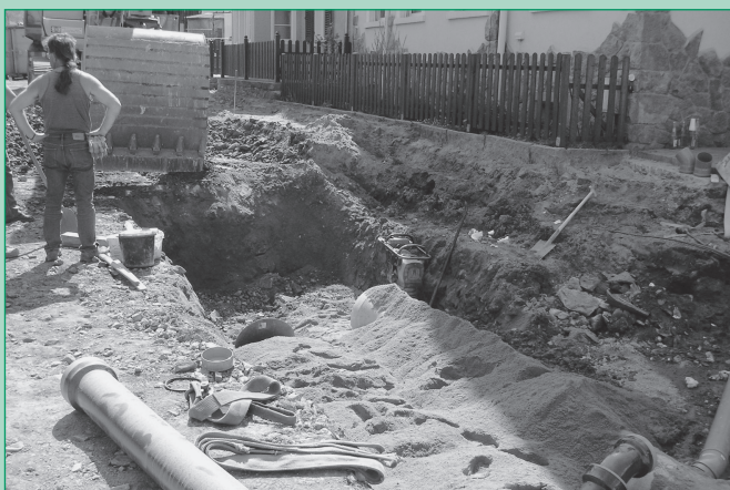
Baufortschritt auf der Niedermuschützer Straße in Zehren. Verlegung Schmutz- und Regenwasserkanal sowie Straßen- und Gehwegausbau.
