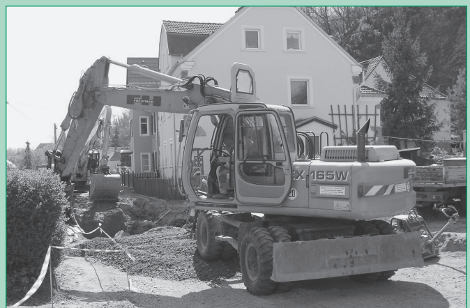
Baufortschritt auf der Niedermuschützer Straße in Zehren. Verlegung Schmutz- und Regenwasserkanal sowie Straßen- und Gehwegausbau.
