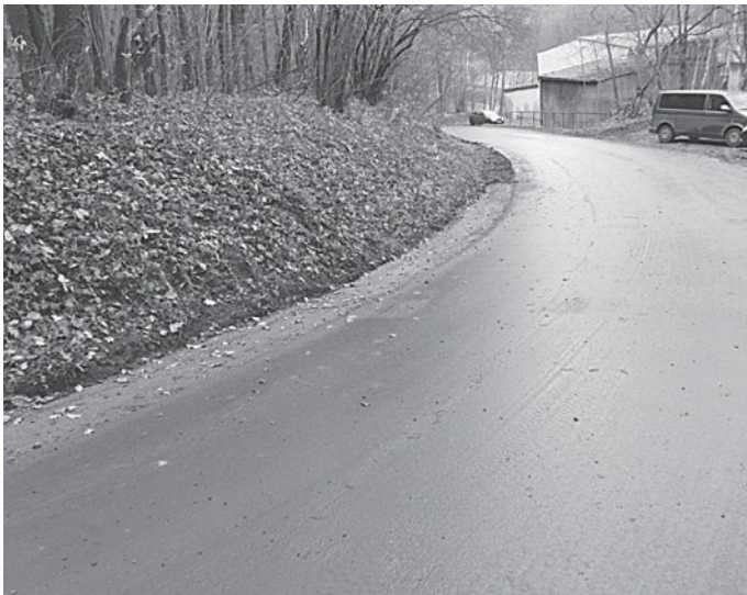
Hochwasserschadensbeseitigung Sofortmaßnahme – Bankett Seilitzer Berg
