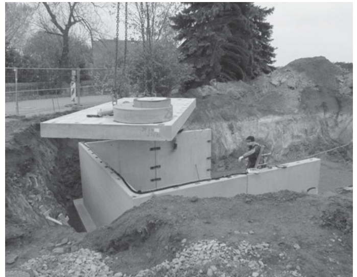
Errichtung Feuerlöschzisterne im OT Löbsal, neben Parkplatz „Jägerheim“
