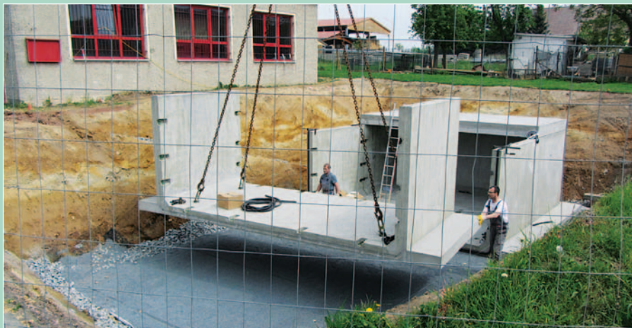
Eine Feuerlöschzisterne für 100 m 3 Löschwasser wurde im Ortsteil Diera errichtet
