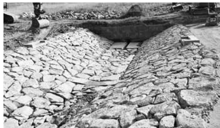
Hochwasserschadensbeseitigung Regenüberlaufbecken Niedermuschütz/Widderbach
