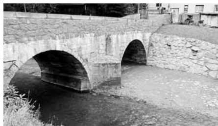
Beseitigung Hochwasserschaden Wiesenwegbrücke Schieritz
