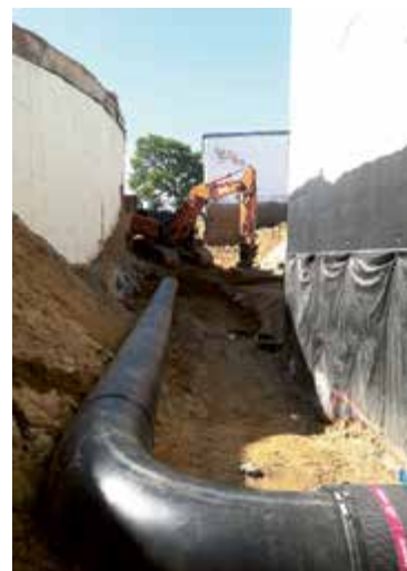
Der Hochbehälter wurde in das neue Schiebergebäude eingebunden.
