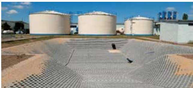
Ein Schlammbecken wurde in diesem Jahr bereits saniert.
