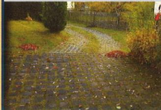
Befestigung von Parkplätzen und sonstigen verkehrsberuhigten Flächen durch Pflastersteine mit wasserdurchlässigen Fugen (sogenanntes Ökopflaster) oder durch Rasengittersteine
