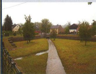
Kleine Rückhaltebecken oder Teiche können das Niederschlagswasser zunächst in der Fläche zurückhalten und somit den oberflächlichen Abfluss dämpfen.
