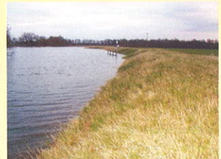
Bei eingedeichten Gewässern Ausuferungen bis an den Deichfuß
